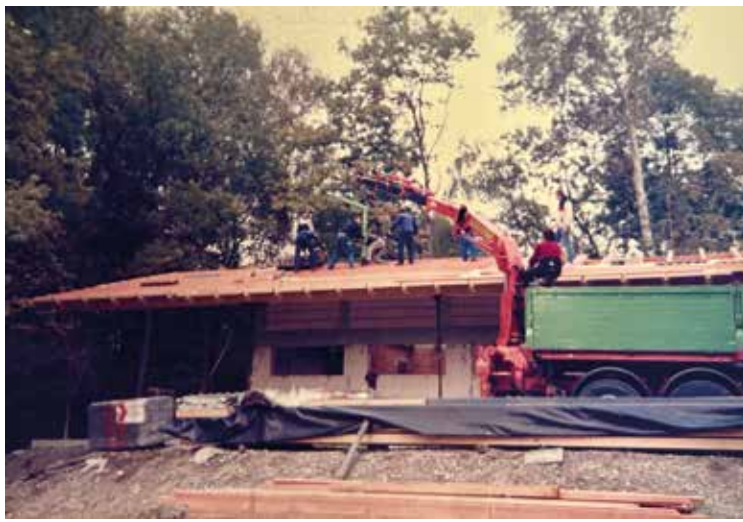
Baufortschritt 1985: Das Dach nimmt Form an.
